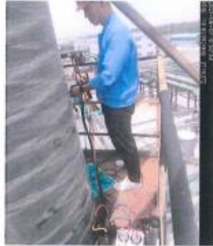
有机废气排气筒（DA001）处理后 Y2
