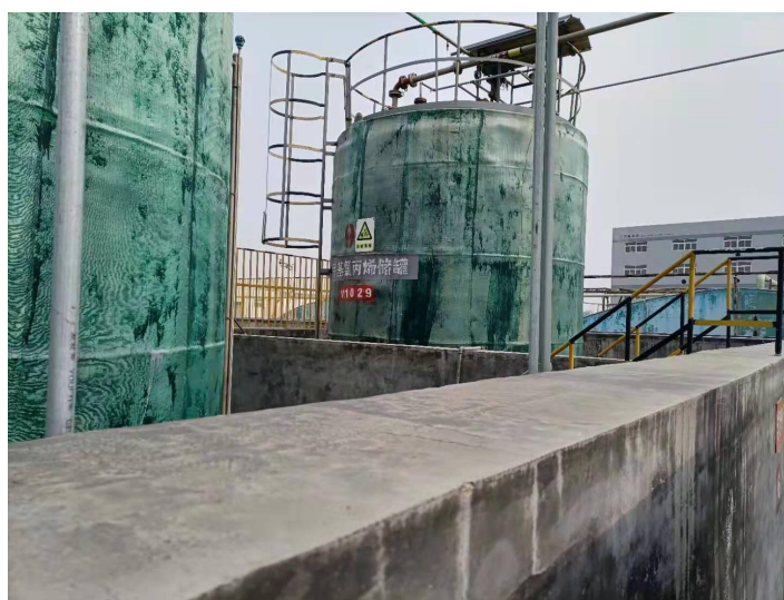
甲基氯丙烯储罐
