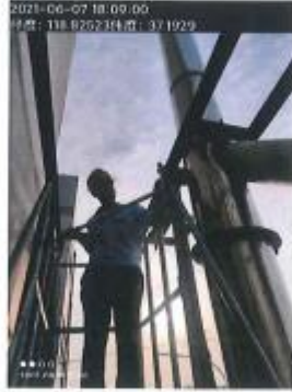
八号车间颗粒物排气筒（DA010）处理后 Y1
